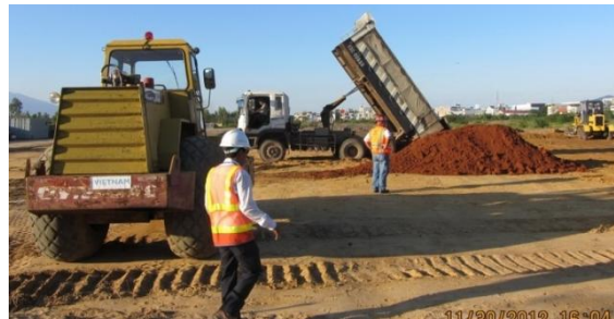
Mang đến vật liệu lấp cho nền kết cấu mố (Ảnh: CDM Smith)
