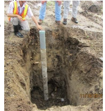
Hố thăm dò trong kết cấu mố (Ảnh: CDM Smith)
