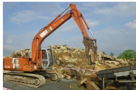
Làm sạch và chuẩn bị nghiền bê tông
