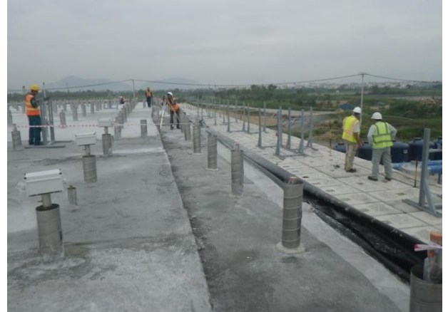
Lớp phủ bê tông trên mố xử lý
